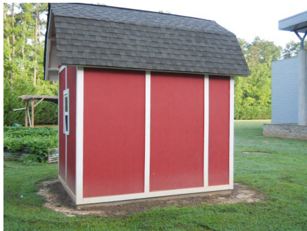
4). East Elevation - Jul 08, 2015
