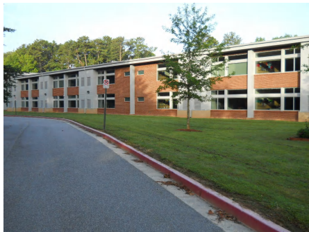
4). East Elevation - Jul 08, 2015
