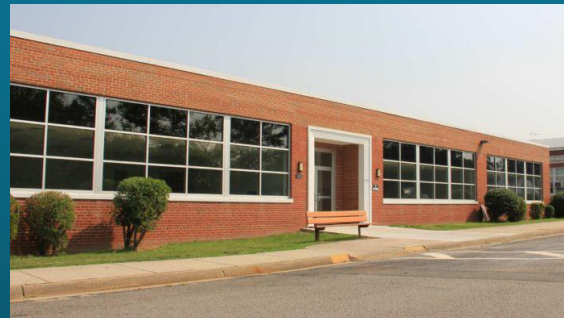
New Kent Site 804-557-2959
