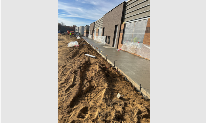
Description First sidewalk pour - East side of Zone F
