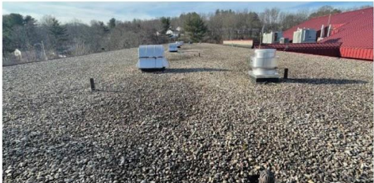
في الصورة أعلاه: جناح مدرسة سليد الإعدادية عام 1958 به سقف سطح معدني 1.5 بوصة مع عازل مضاء باللؤلؤ ثم يحتوي السطح على أحجار البرك لتعزيز الصرف من خلال نظام من المصارف السطحية والمزاريب.
