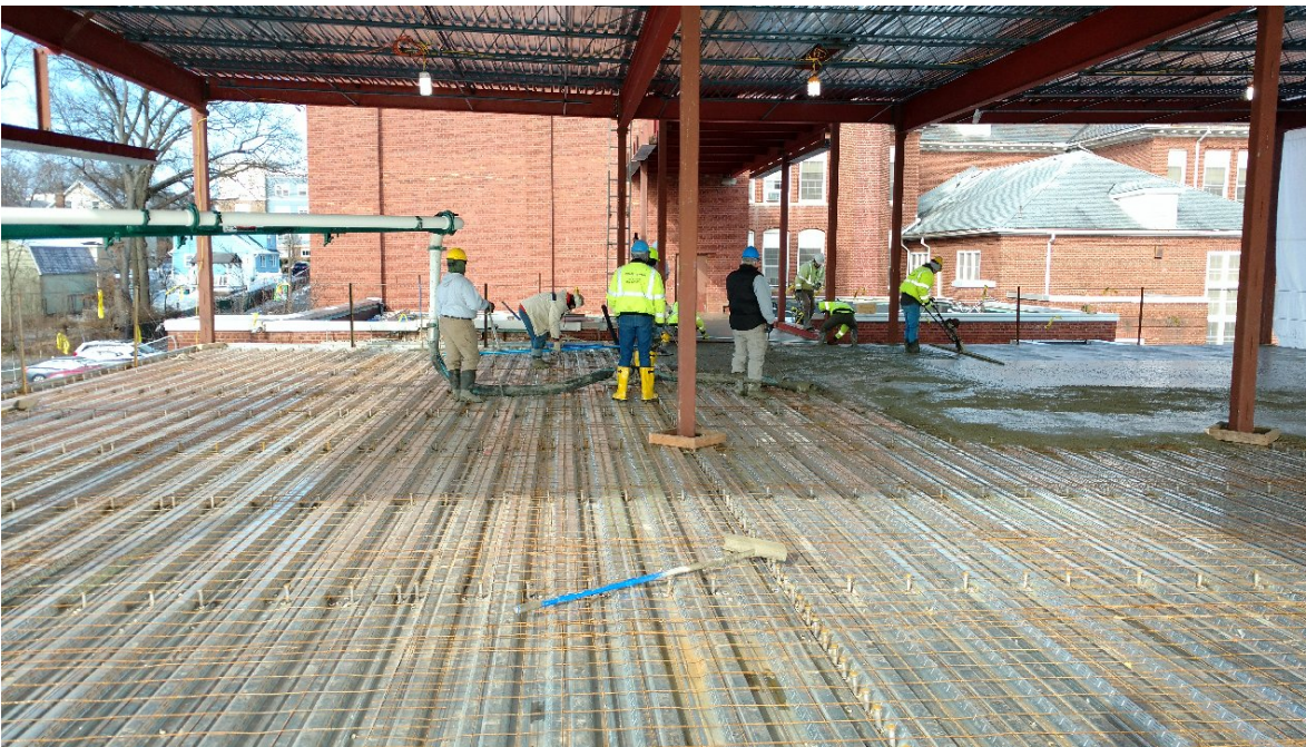
Seth Boyden- Second floor decking concrete pour
