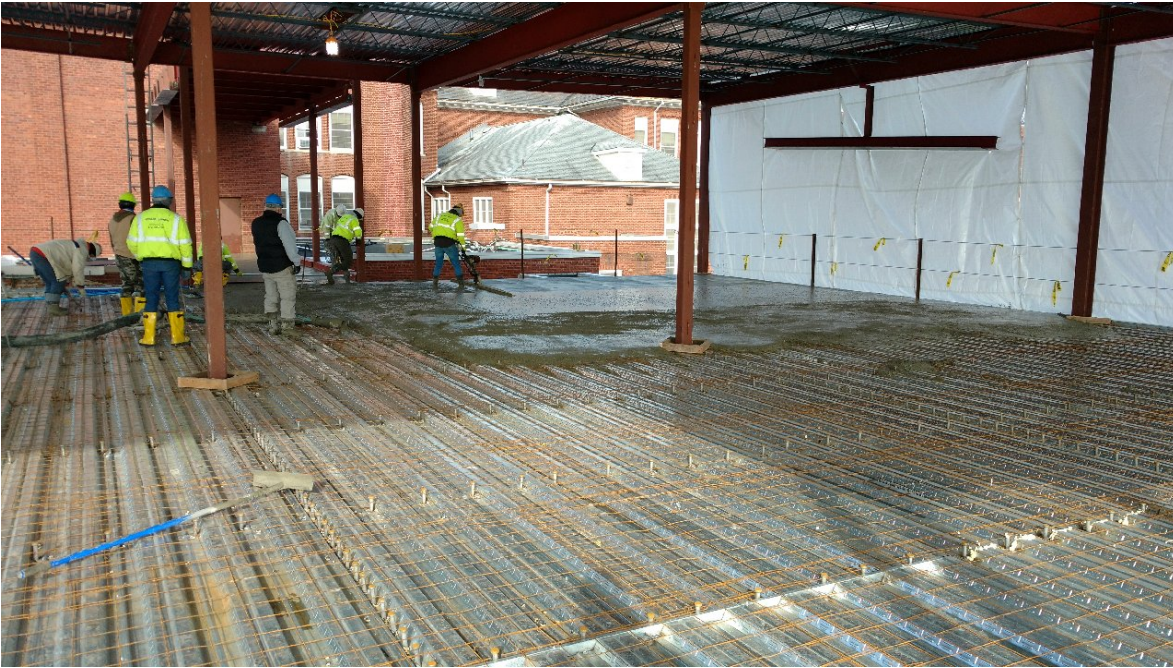
Seth Boyden- Second floor decking concrete pour
