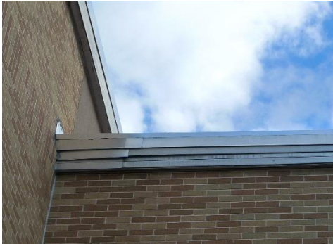
Roof edge flashing
