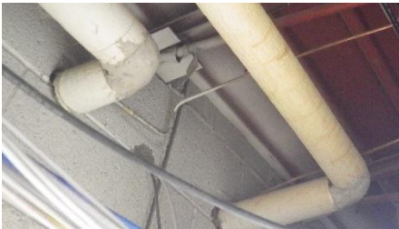
Asbestos Pipe Elbows
