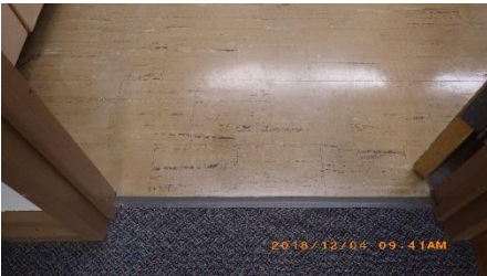
Vinyl asbestos tile (VAT)
