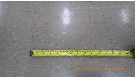
9x9 vinyl asbestos tile (VAT) at stage
