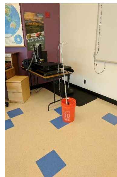
72517-ANX-RMD: Annex room D.
