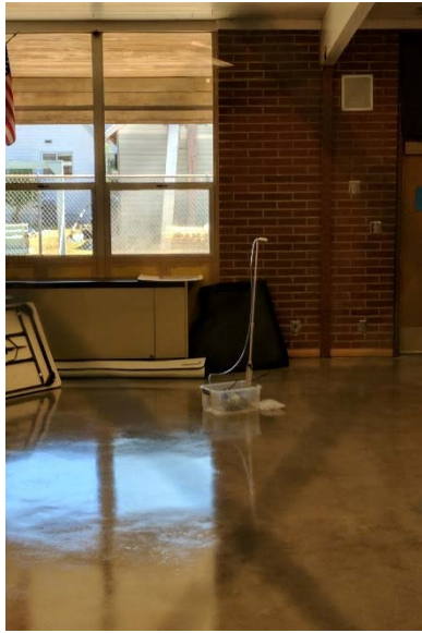
72417-POD-RM9: POD room 9.
