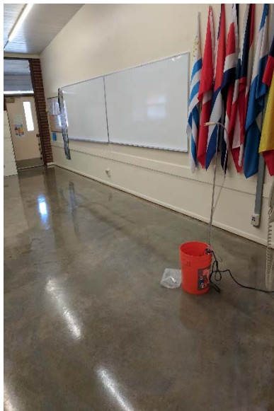
72417-POD-RM1: POD room 13.
