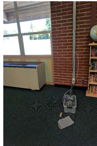
72417-POD-RM15: POD room 15.
