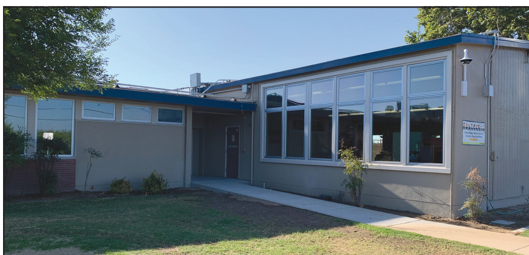
Updated Milgard windows at Terry. Ventanas Milgard actualizadas en Terry.
