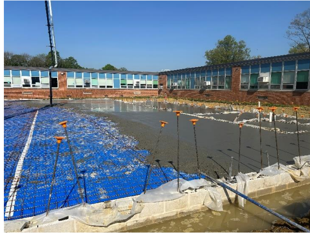
Mann – slab pour in progress
