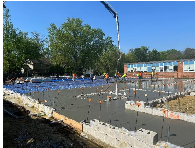
Mann – slab pour in progress
