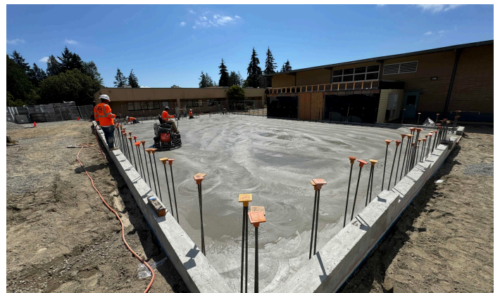
Slab on grade concrete pour
