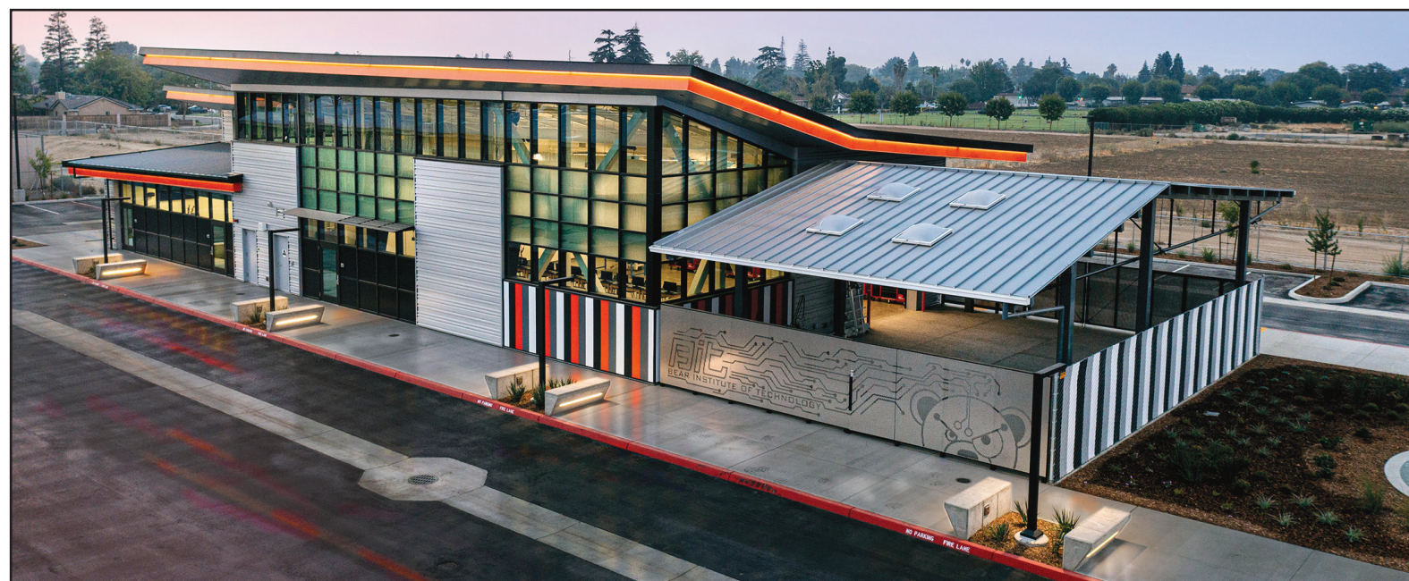
New Career Technical Education building at Selma High. Nuevo edificio de Educación de Carreras Técnicas en Selma High.
