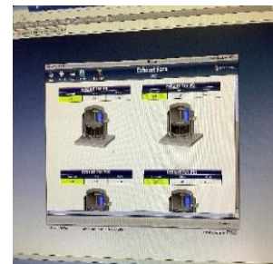
Exhaust fan dashboard
