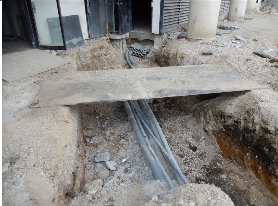
Site Conduit in Transformer Room
