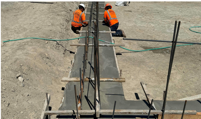
Footings concrete pour
