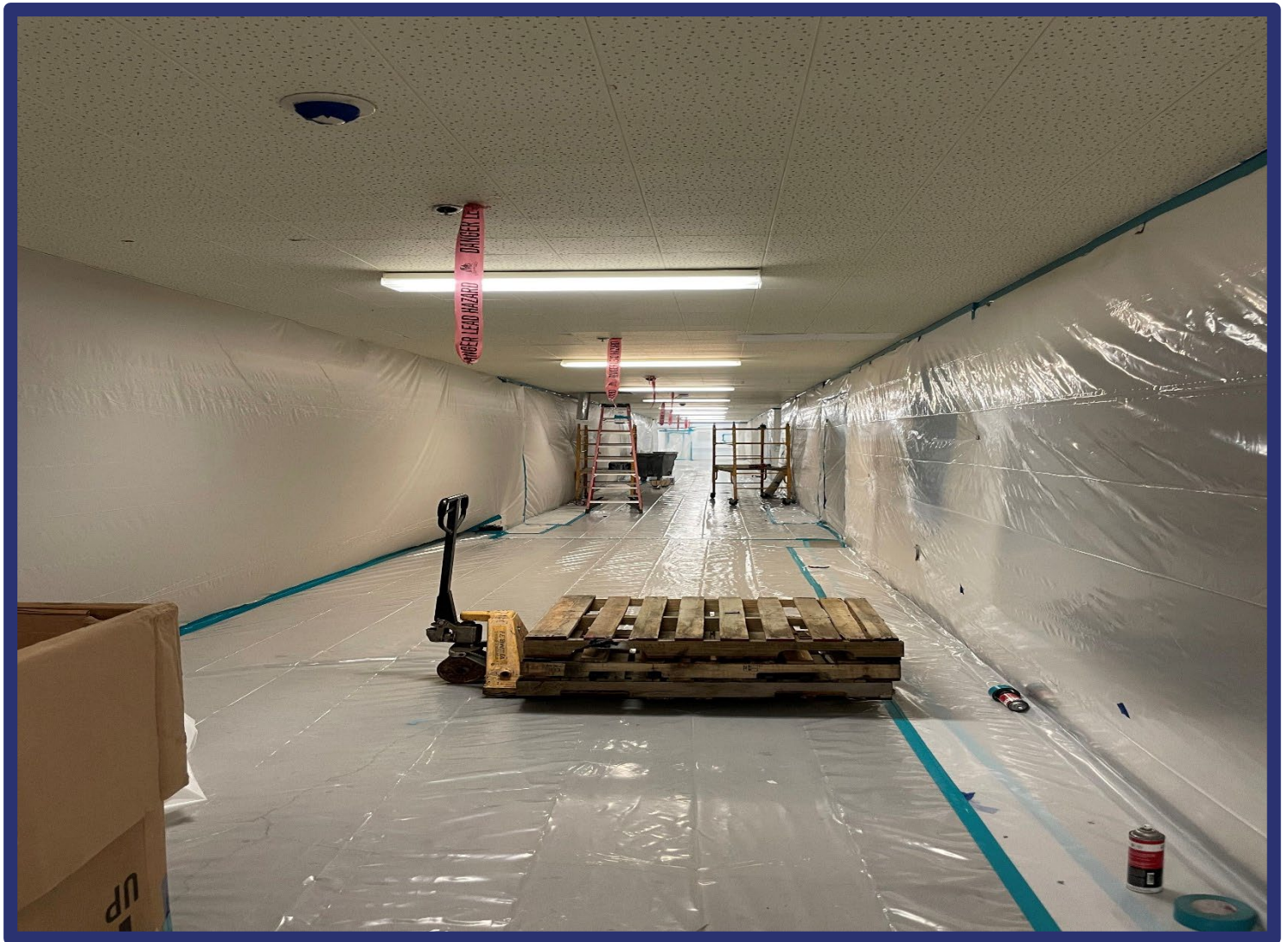
Palisades Abatement Complete
