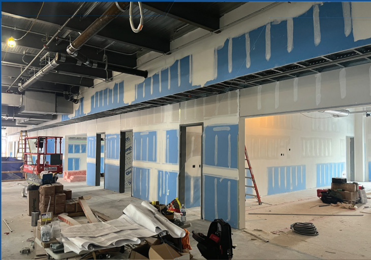
Wachter level 2 Drywall Finishing
