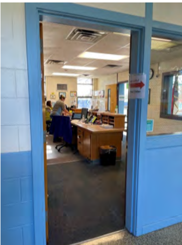
Old wood door frames
