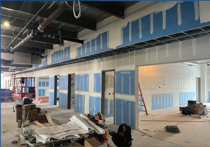
Wachter level 2 Drywall Finishing
