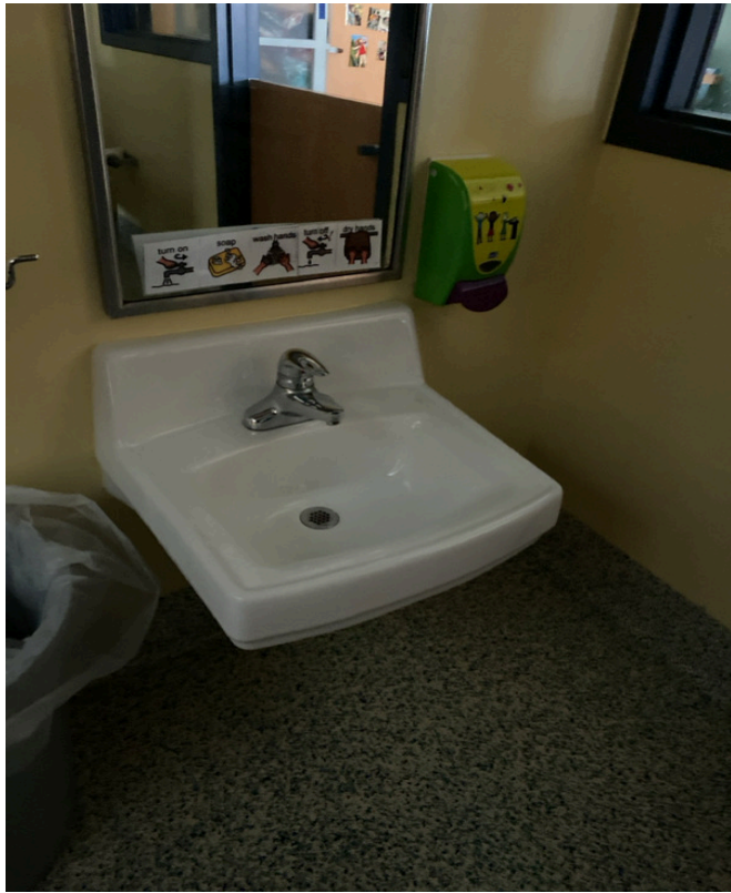
3/12/2024 - 9600-55 - ECC - 002013- Room 308 Unisex Restroom
