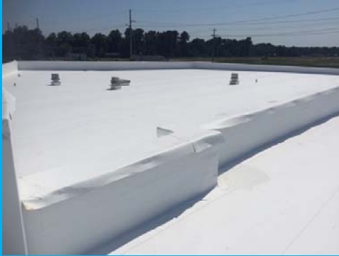
New TPO Membrane
