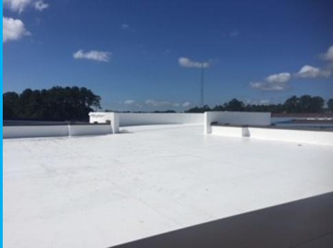
New TPO Membrane
