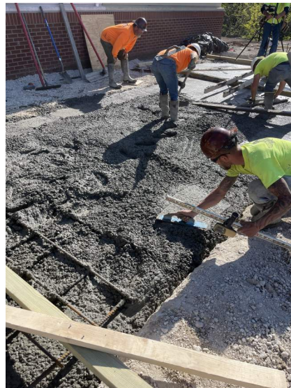
EPiC Elementary - Footing Pour
