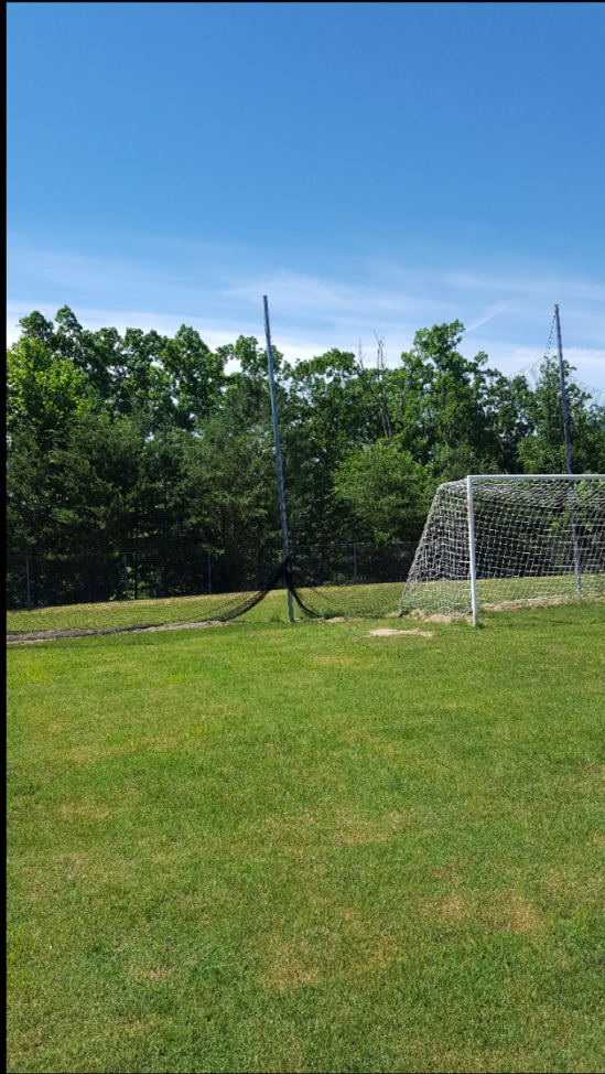
03. End Netting Sag
