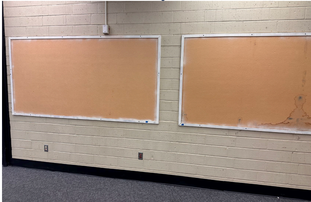
Room A-12 Primer coat
