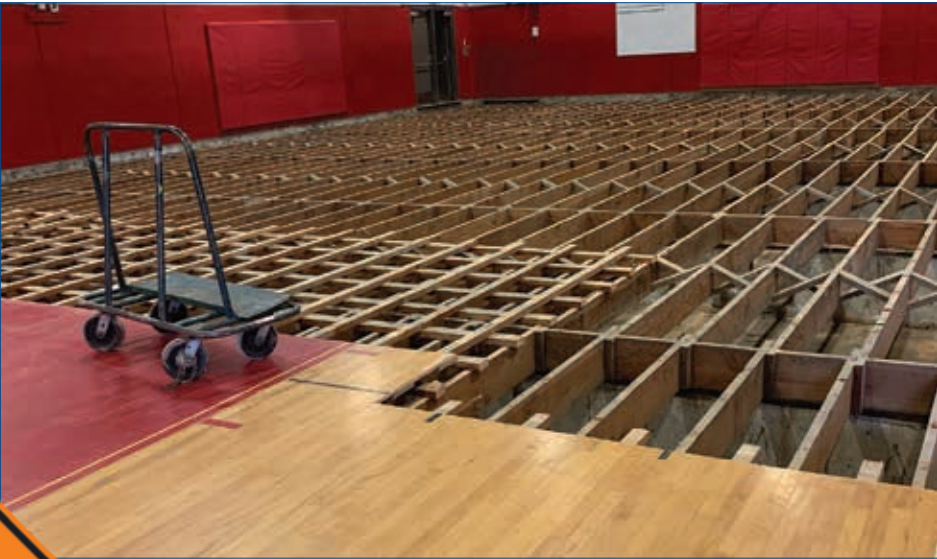
Arriba: El piso en el gimnasio pequeño de Poynter está siendo reemplazado.
