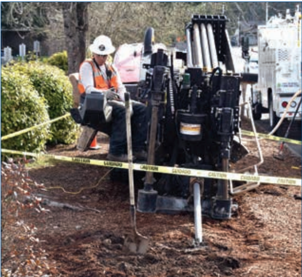
Una máquina taladradora excava un hoyo subterráneo para que el conducto del cable de fibra óptica sea instalado. Este proceso se repetirá a medida que se instalen los anillos de la red de fibra óptica en todo el distrito.
