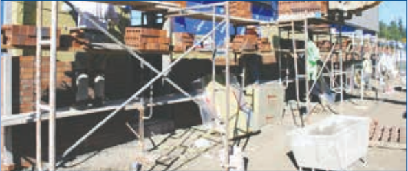
W.L. Henry: albañilería de la pared exterior
