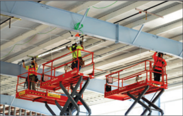
▲ Escuela Primaria Ladd Acres: se está instalando la estructura en el techo del gimnasio.
