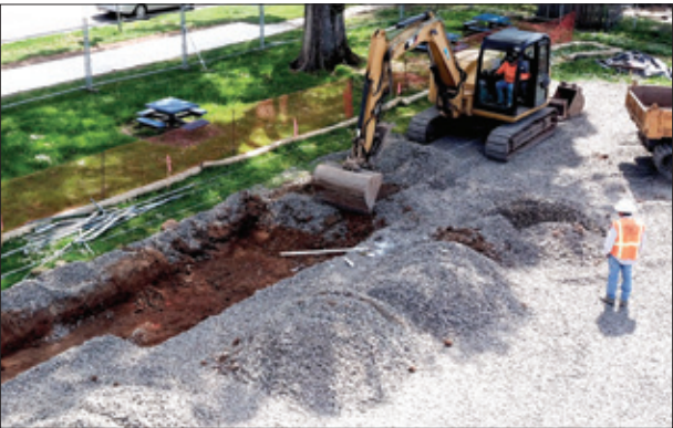
▲ Centro de Caminos a la Profesión y a la Universidad: se están excavando las zanjas para los cimientos del nuevo edificio.
