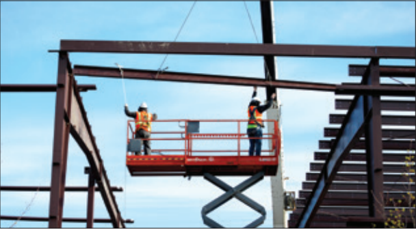
Instalar el acero estructural
