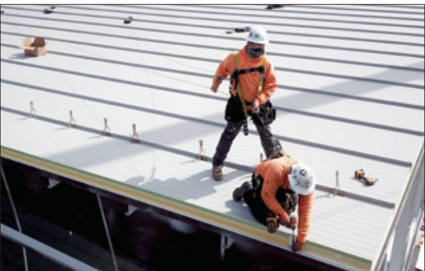
▲ Escuela Primaria McKinney: se está instalando el último panel del techo en el gimnasio.
