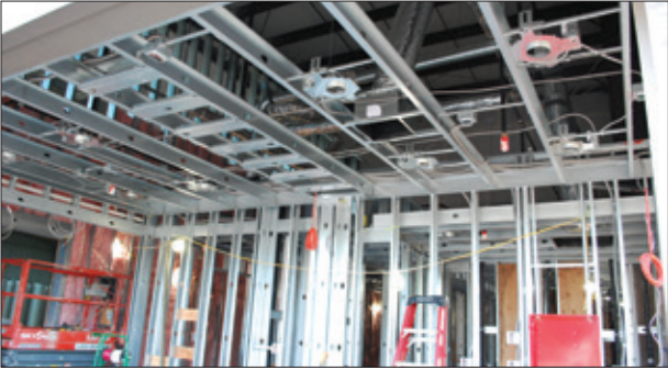
Instalar la estructura interior, los conductos y la plomería
