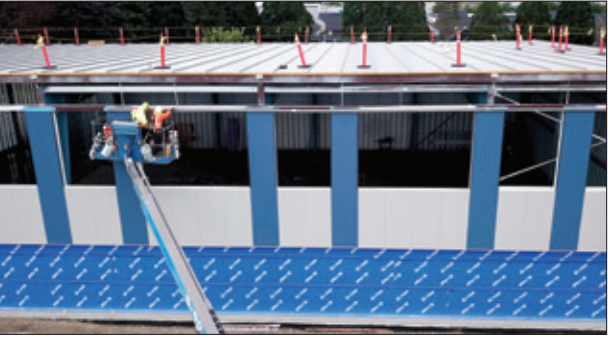
Finalizar la estructura exterior, instalar el revestimiento
