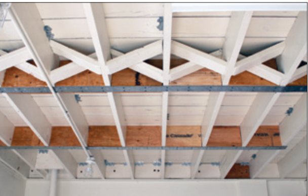
▲ Edificio Peter Boscow: se están agregando refuerzos sísmicos a la estructura.
