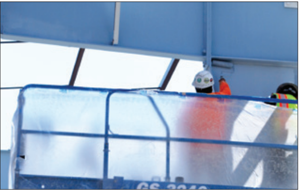
▲ Escuela Primaria Jackson: se está preparando y pintando el acero estructural en el gimnasio.
