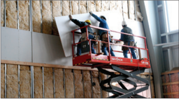
Aplicar el aislamiento y las placas de yeso
