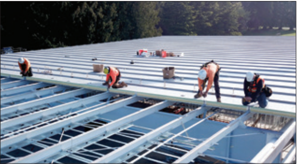
Instalar los paneles del techo
