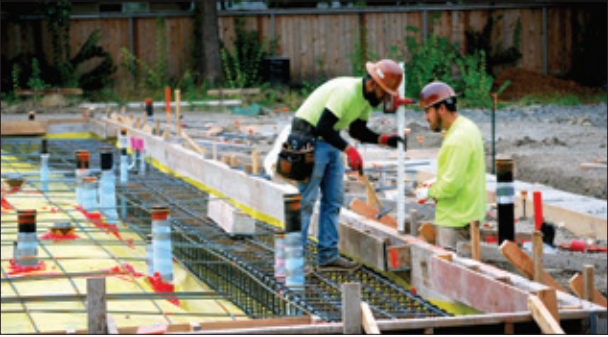
Construir los cimientos
