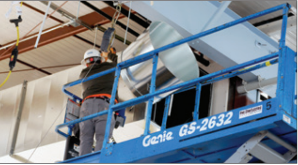
Instalar los conductos de HVAC (calefacción, ventilación y aire acondicionado)
