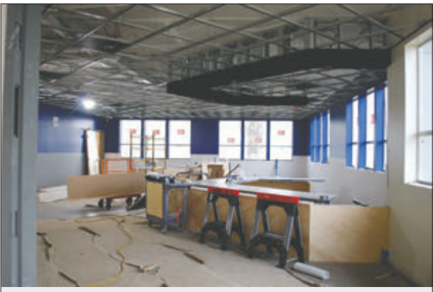
▲ Centro de Caminos: Se están instalando gabinetes en el área del vestíbulo.
