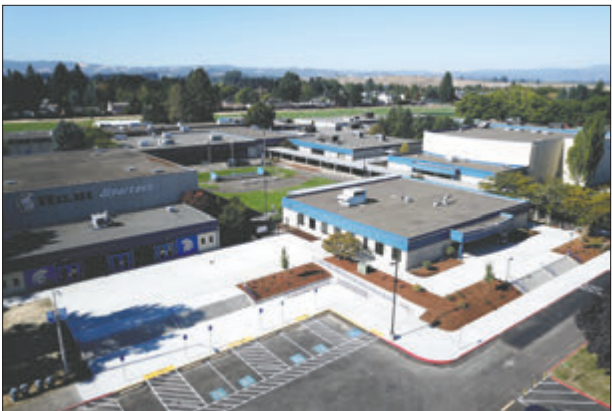
▲ Hilhi: Nuevas explanadas y pasillos de concreto transforman la fachada de la escuela.
