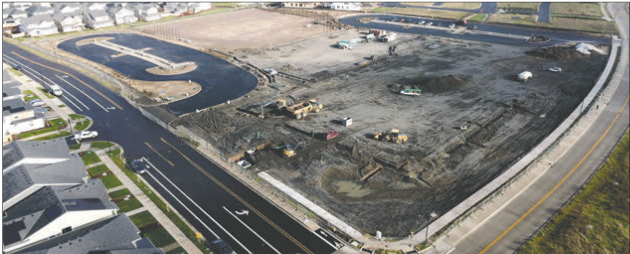
▲ ES29: El trabajo de la Fase 1 en 2021 en este sitio, incluyó los cimientos para el campo de césped artificial y las áreas donde se dejan o recogen a los estudiantes/estacionamientos. El edificio se construirá donde ahora se están realizando las zanjas para los servicios públicos.
