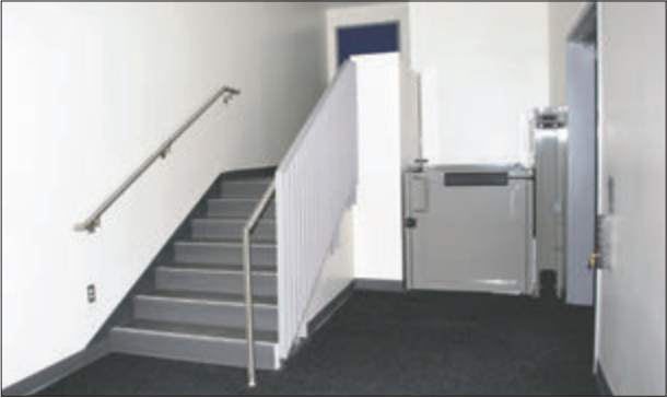
▲ Ladd Acres: Nuevo elevador junto a las escaleras del escenario proporciona acceso ADA.
