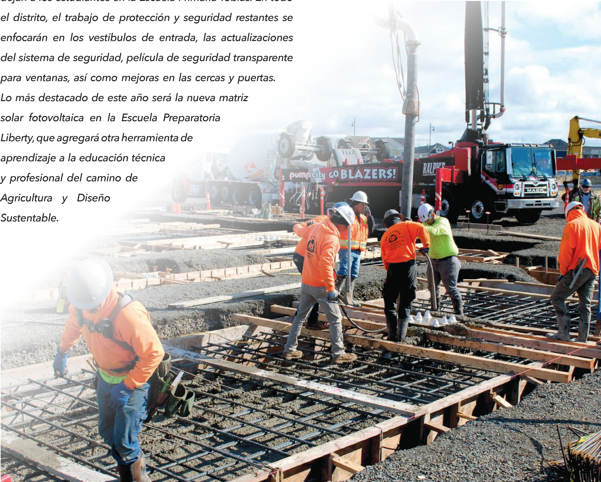
▲▼ ES29 (Sur de Hillsboro): Se instalaron armazones y barras de refuerzo para los cimientos en la esquina sureste del edificio. Se vertió hormigón en los marcos para formar la base de los cimientos del edificio.
