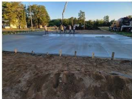
Pouring the concrete (August 15)
