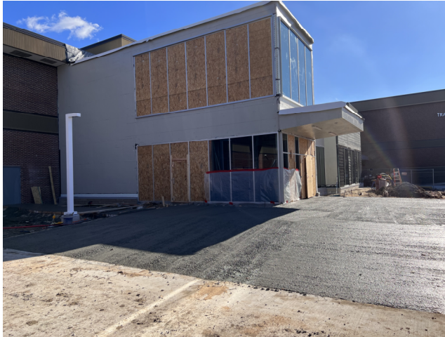
Exterior Concrete Pour
