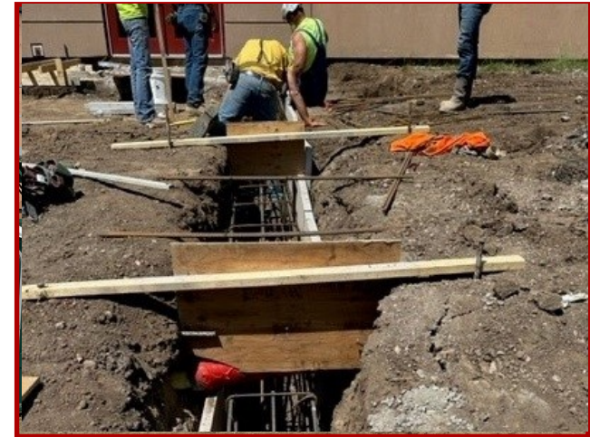
Placed Rebar for Next Pour
