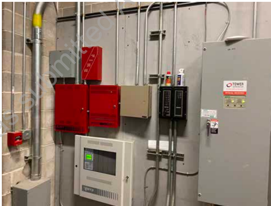
● D2. 18: Fire Alarm Head End
