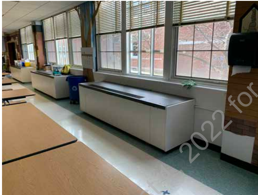
● D1. 27: Existing Unit Ventilator.
