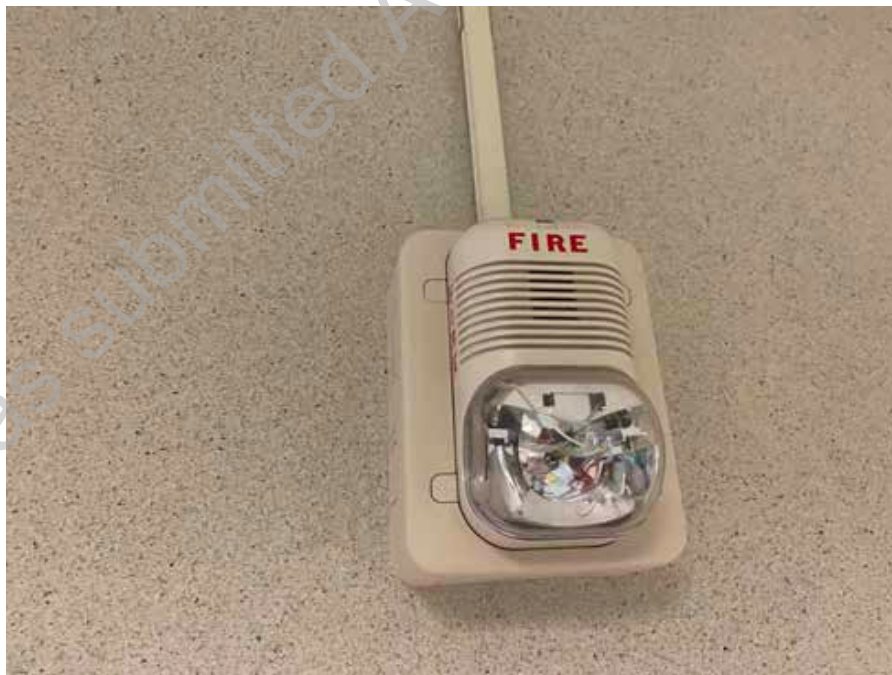
● D2. 12: Fire Alarm HornStrobe.
