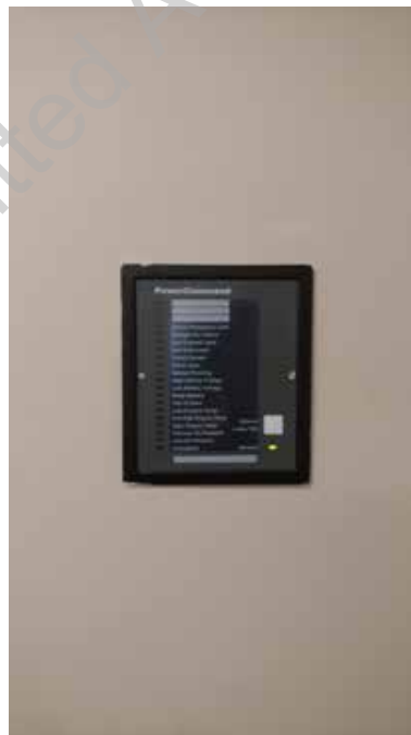
● D2. 24: Generator Remote Annunciator
