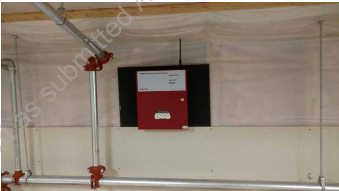
● D2. 12: Fire Alarm Communicator
