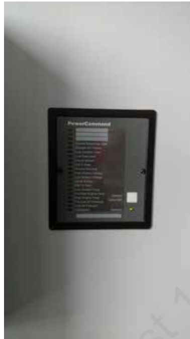
● D2. 17: Generator Remote Annunciator
