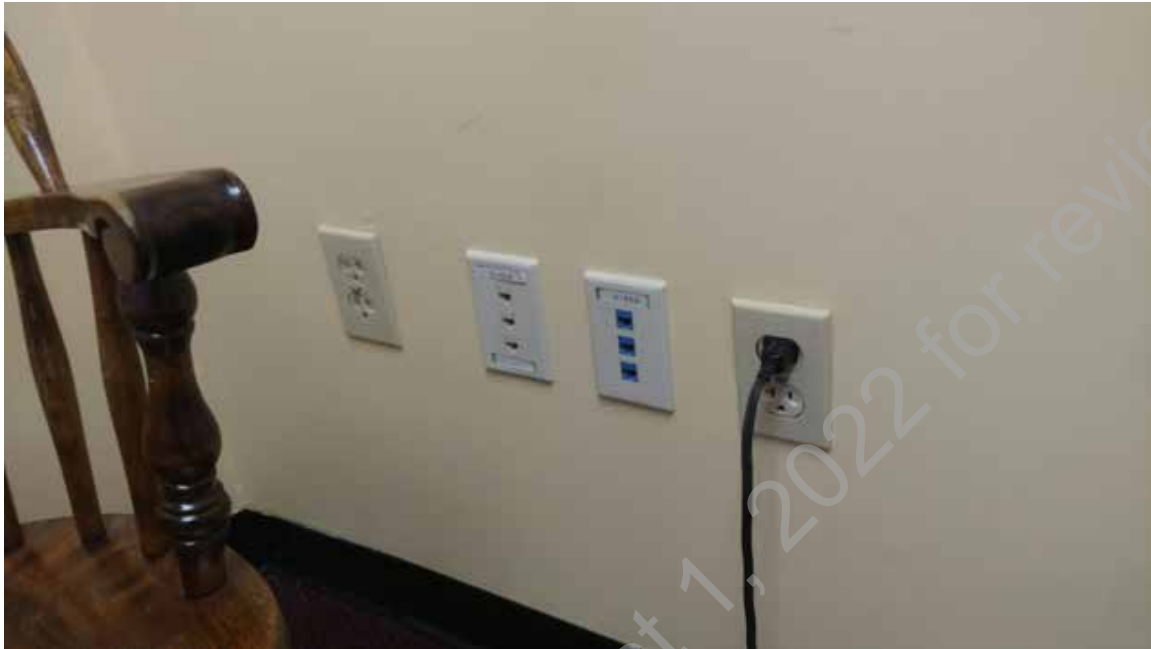
● D2. 3: Data Work Area Outlets
