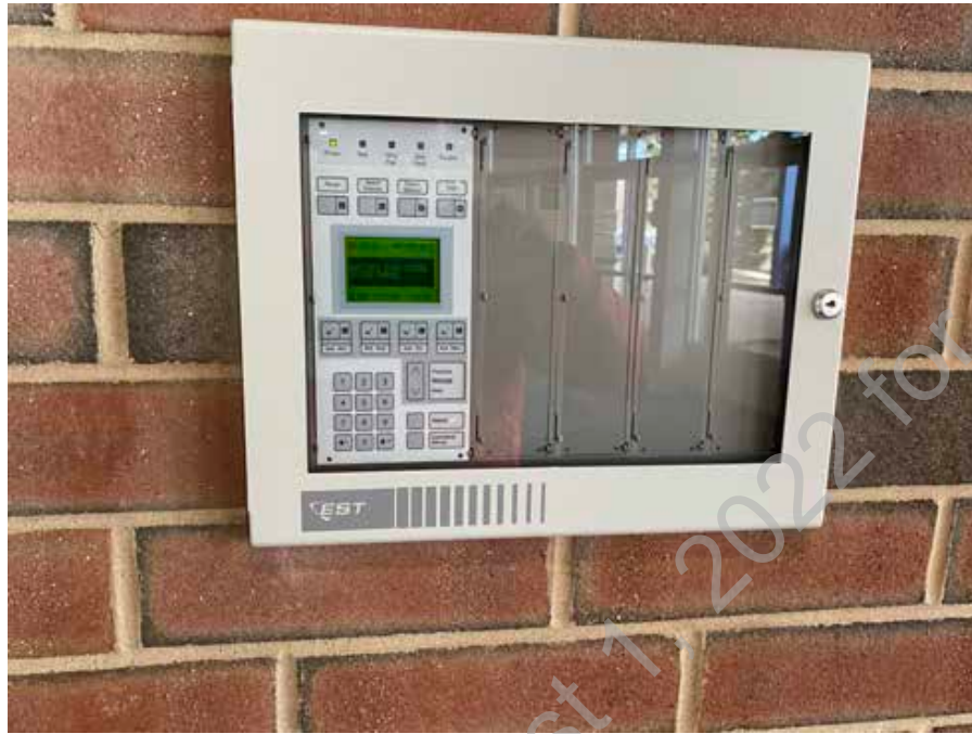
● D2. 19: Fire Alarm Remote Annunciator
