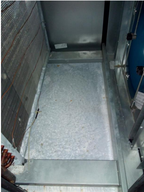
AHU09 Drain Pans
