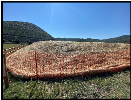
Capa de paja y tapa terminada C&D Pile - este
