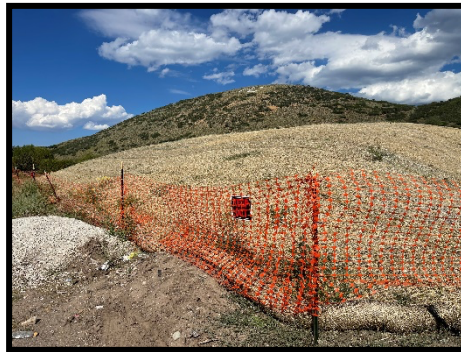
Postes, vallas, señalización, control de erosión.
