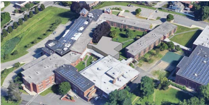
vista aérea que muestra la colocación de la adición
