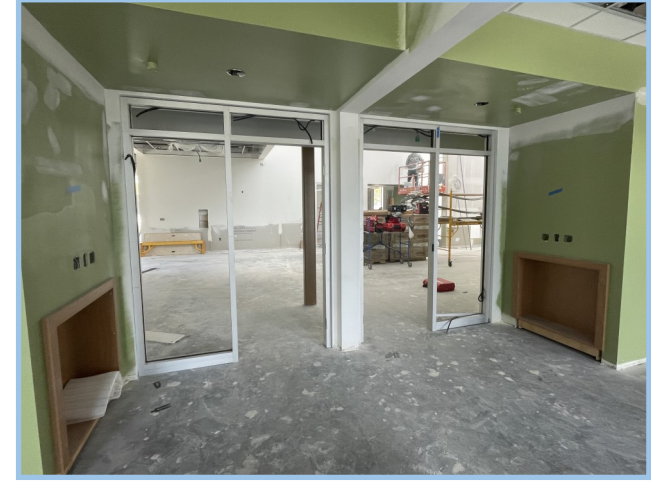
Aluminum Door Frame Install
