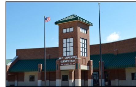
Escuela Elemental Chalmers Grados 2-4 | Construida en el 2000
