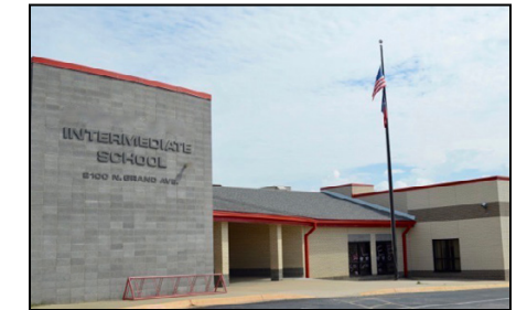
Escuela Intermedia Gainesville Grados 5-6 | Construida en el 1997
