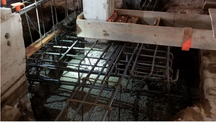
Preparing for new foundation concrete pour
