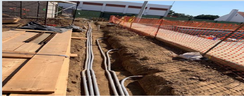
La Puente HS Pool – Install Electrical Conduits
