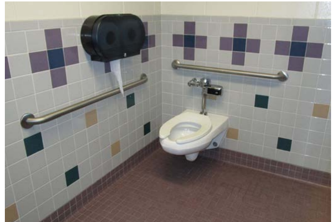
ADA ACCESSIBLE TOILET
