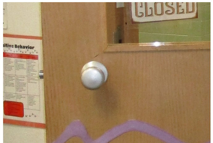
ROUND DOOR KNOBS NOT ADA COMPLIANT
