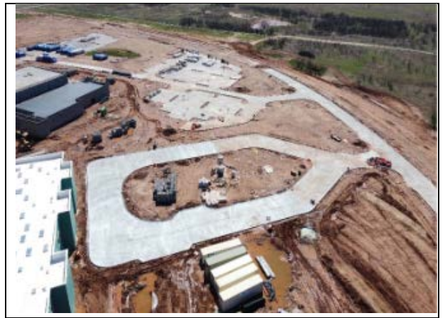
Bus Loop Poured
