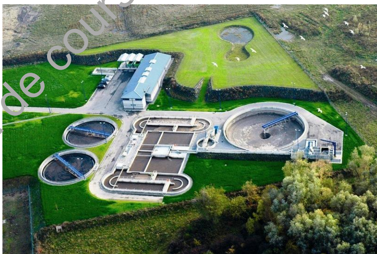
Doc 1. Photographie aérienne d'une station d'épuration.
