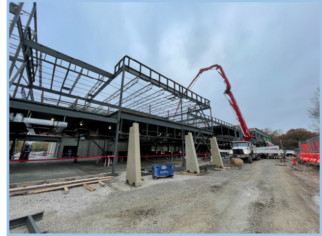
Area A Slab on Deck Pour
