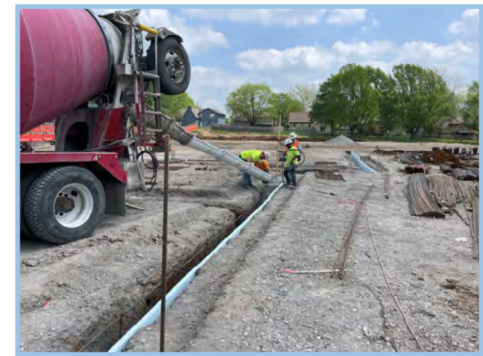
Pour Area B Footings
