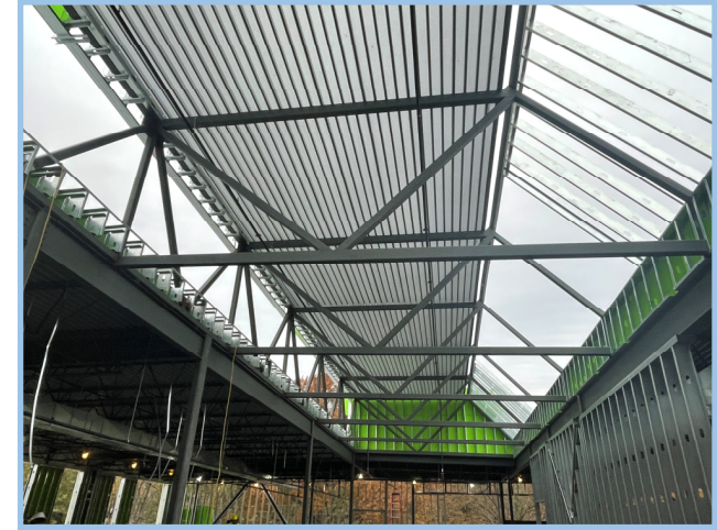
Area A Slab on Deck Pour
