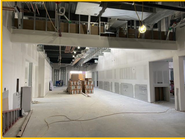
Main Corridor Drywall
