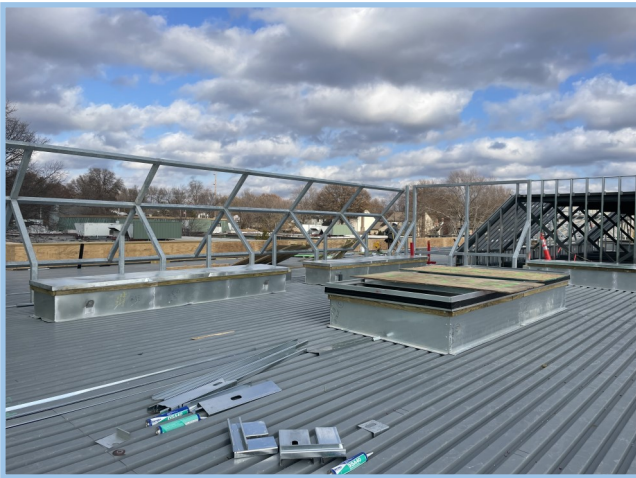
HVAC Curbs Set
