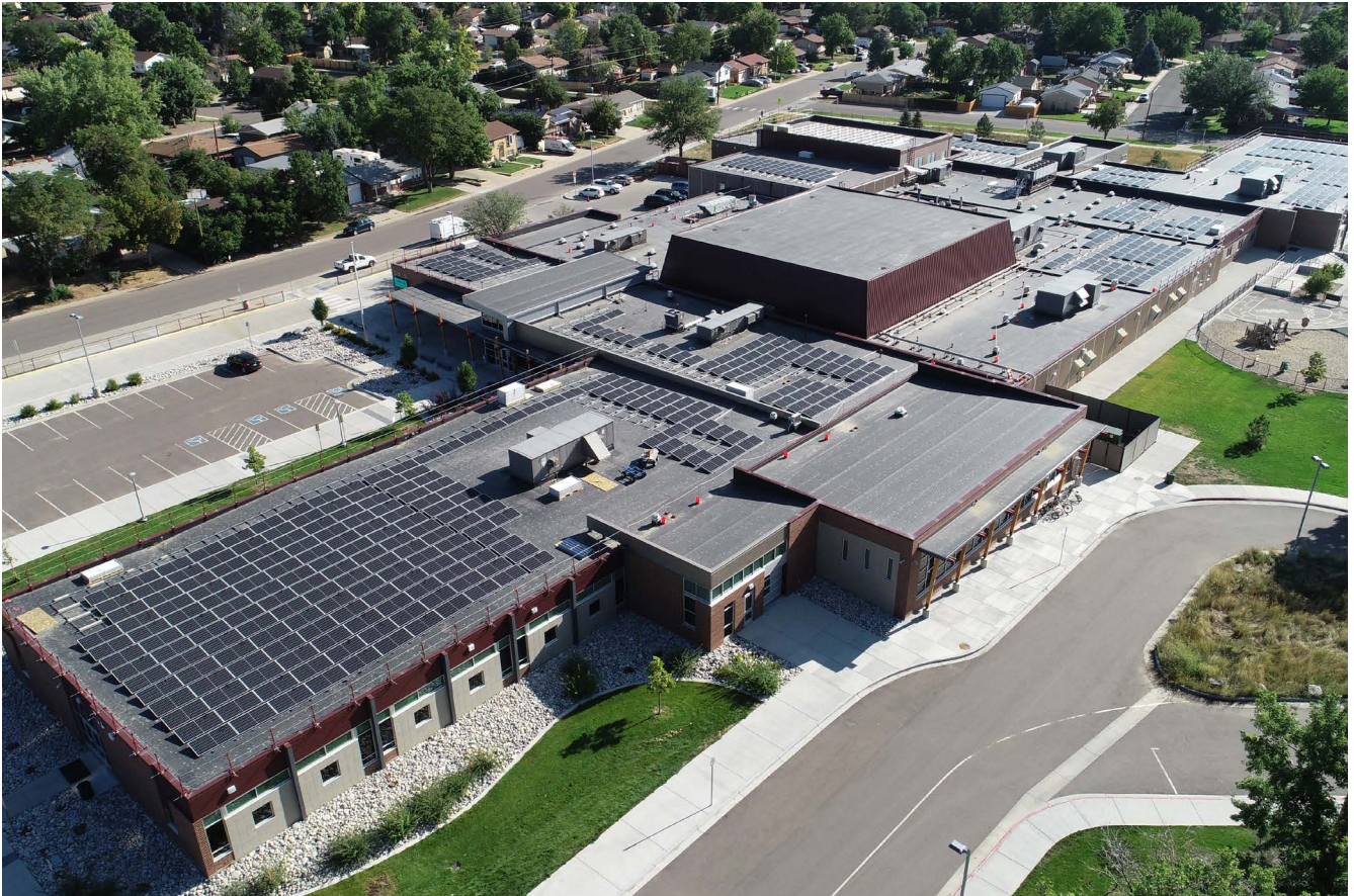
Instalación final del panel solar de 365 kW en el tejado del laboratorio STEM.
