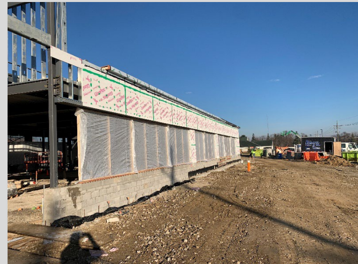
Exterior Metal Stud Framing
