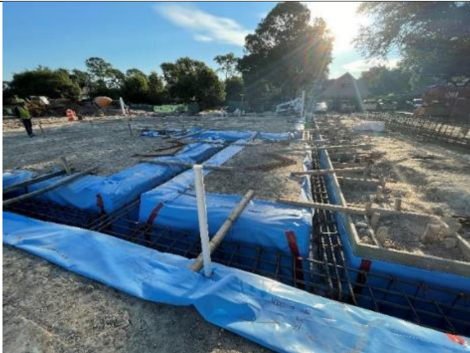
Last remaining area needing concrete pour
