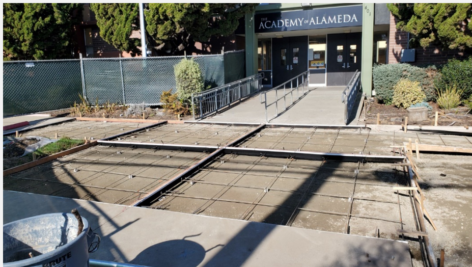
Prepping for concrete pour
