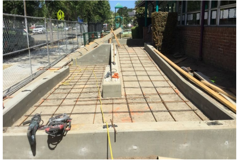
Ramp rebar before concrete pour
