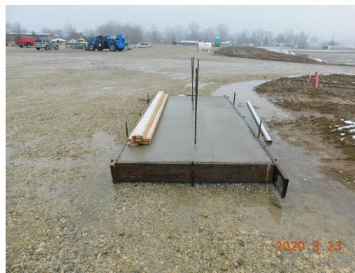
Concrete Pour for the masonry mock-up
